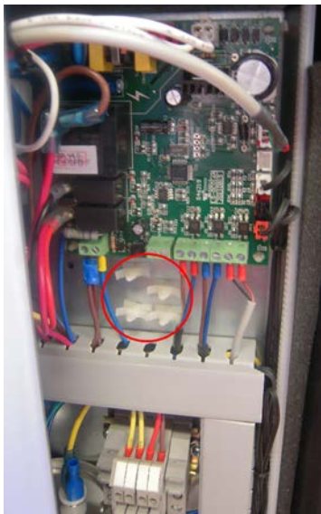
8) Installieren Sie die 4 Clips unterhalb der Karte der Wärmepumpe.
